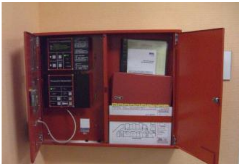
Feuerwehr-Informationszentrale (geöffnet)
