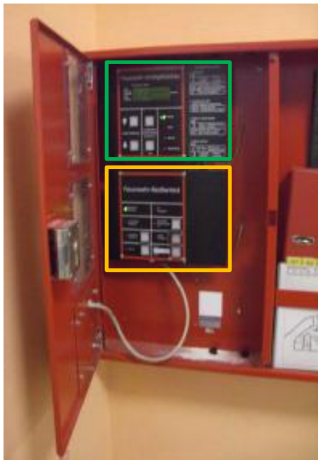
Feuerwehr-Anzeigetableau Feuerwehr-Bedienfeld
